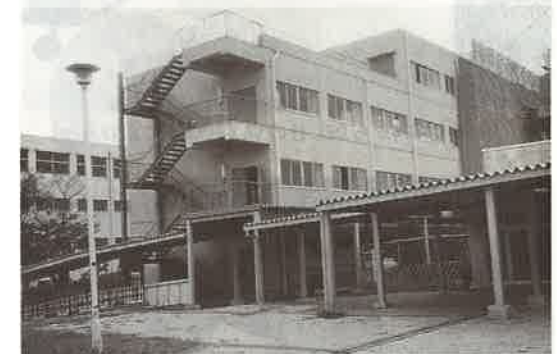
増築された工業化学科棟と高学年棟
